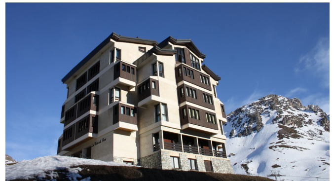
Façade Ouest et loggias fermées, CAUE, 2015
