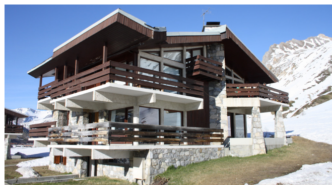
Soubassement en pierre, CAUE, 2015
