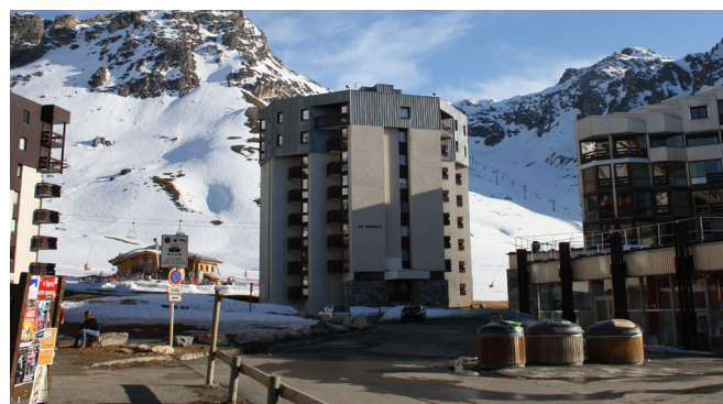
Couronne de métal marquant la toiture, CAUE, 2015
