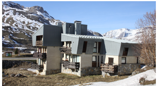
Le Cafetan et ses toitures métalliques, CAUE, 2015
