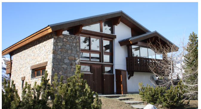
Le Colombero mélange de bois et de pierre, CAUE, 2015
