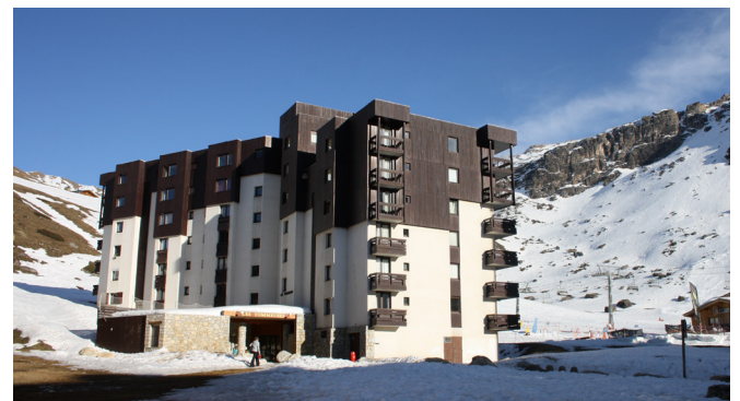
Balcons et façade nord fermée aux Tommeuses, CAUE, 2015
