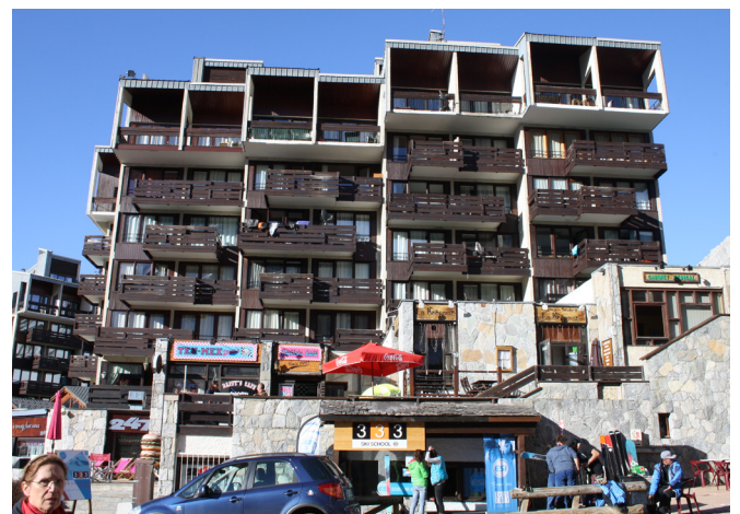
Menuiseries et encadrement bois, CAUE, 2015
