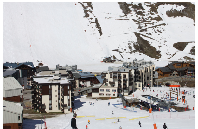
Vue d'ensemble des bâtiments, CAUE, 2015
