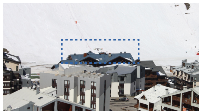
Vue sur la toiture métallique à deux pans, CAUE, 2015
