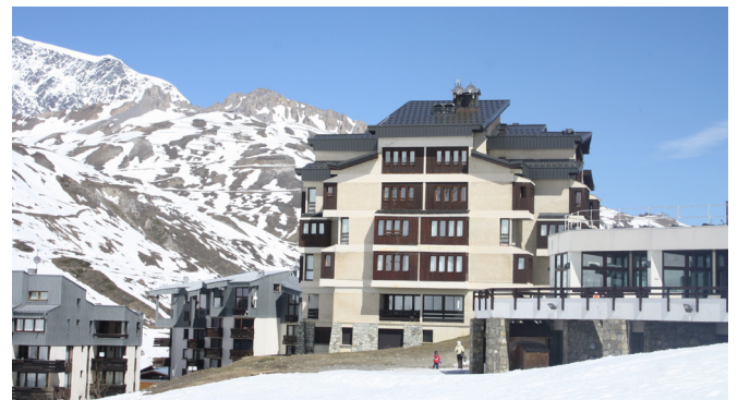
Face sud ouest et ouverture sur les pistes, CAUE, 2015
