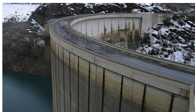
Barrage du Chevril à Tignes, CAUE, 2007
