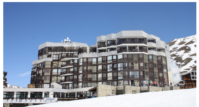
Façade ouverte sur les pistes et galerie, CAUE, 2015
