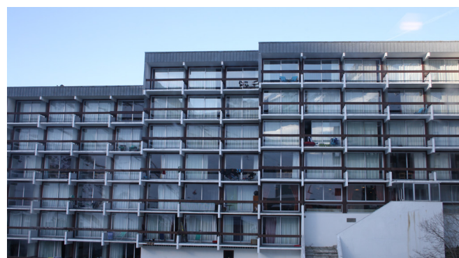
Travées verticales rythmant la façade, CAUE, 2015
