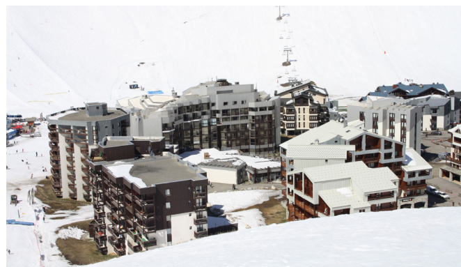
Des formes de toitures complexes, CAUE, 2015
