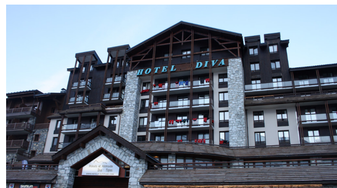
Façade principale faite de pierre et de bois, CAUE, 2015
