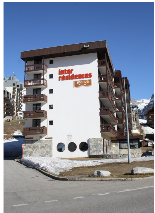
Façade nord et soubassement pierre, CAUE, 2015
