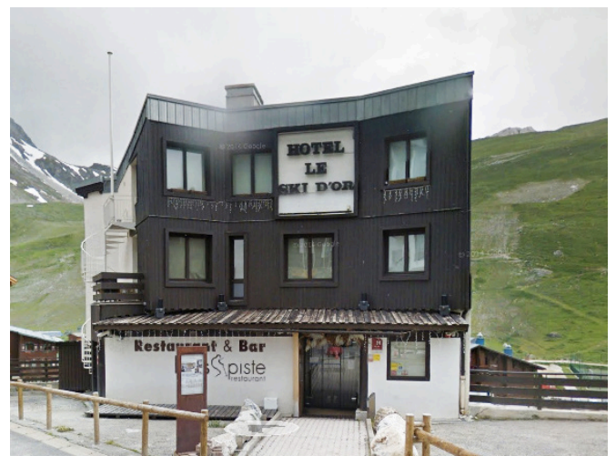
Entrée faite de bois et couronne métallique, et escalier de secours, CAUE, 2015
