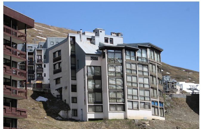
Façade arrondie vitrée tournée vers le paysage, CAUE, 2015
