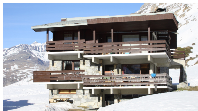
Larges ouvertures et balcons en bois, CAUE, 2015
