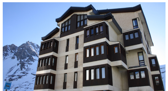
Bords de toiture retroussés, CAUE, 2015
