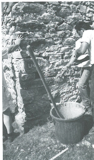
L' utilisation de coulis permet d'homogénéiser les mortiers et de remplir les vides de la construction.
